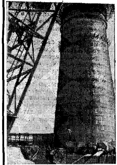
Полным ходом развернулись работы на всесоюзной ударной комсомольской стройке — одной из крупнейших в стране — Костромской ГРЭС. Сооружение ее ведется индустриальными методами с применением сборного железобетона.
