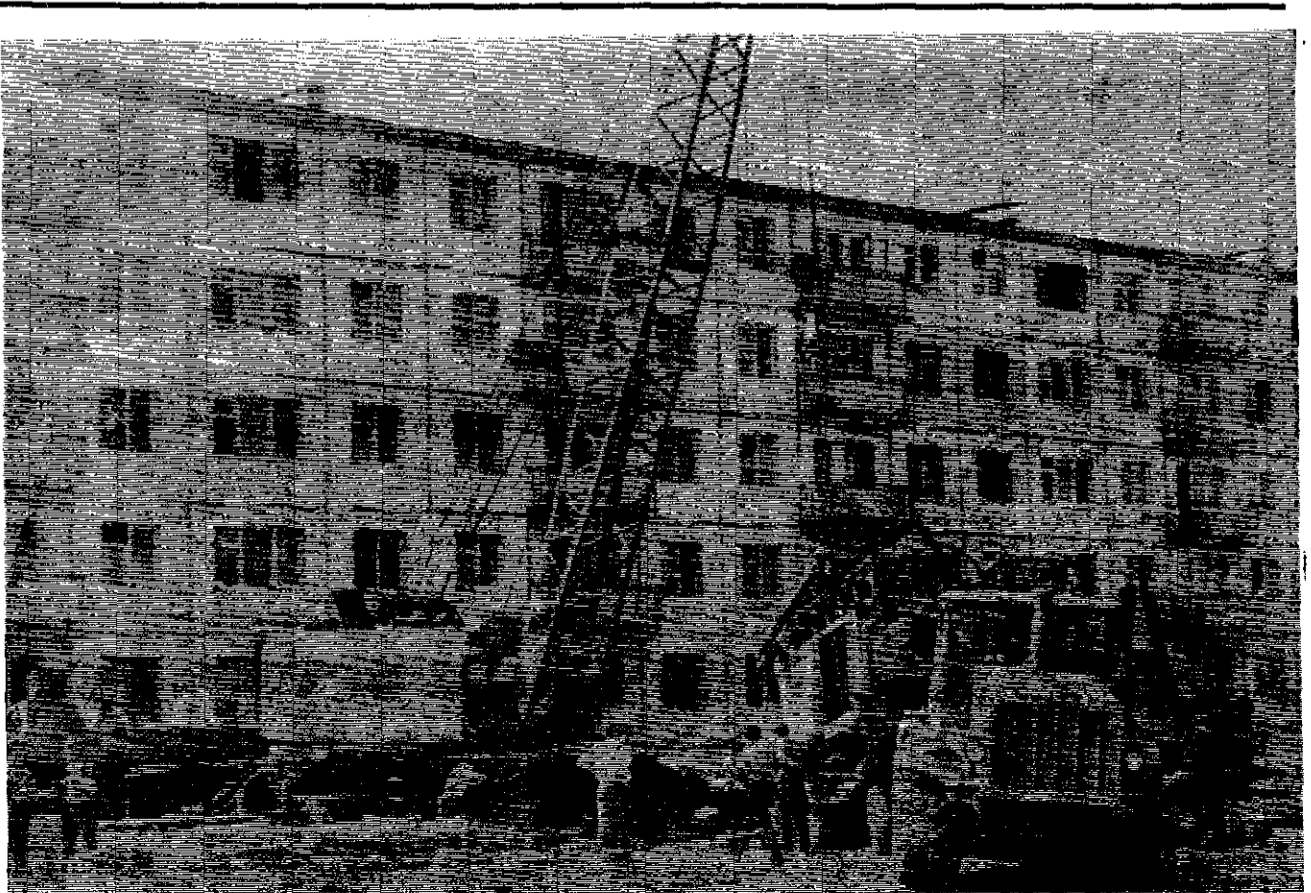
растет и ширится. Во втором микрорайоне подъемных кранов над строящимся зданием. Этот снимок сделал нашим общешкольным корреспондентом В. Приотиным неслучайно: выполнив свою роль, уходит с крана. В этом здании уже хозяйничают люди.
