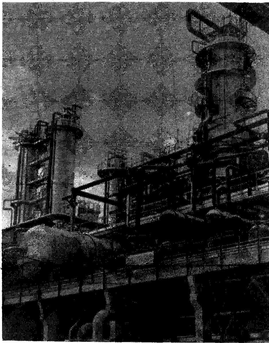
Установка АВТ, построенная в 1971 году на Киришском нефтеперерабатывающем заводе. Фото С. Маракулина.
